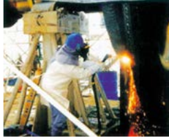
発電用タービンシャフトの解体
