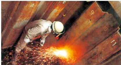
シートパイル溶断
